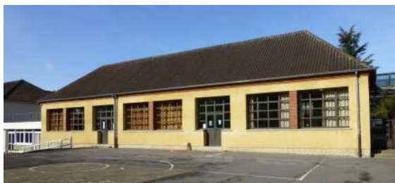
Toitures de l'école
